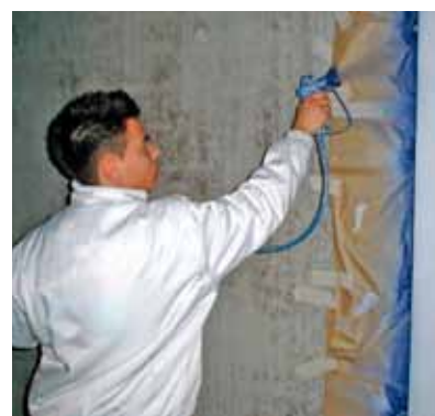
Het opbrengen van brandwerende coating
