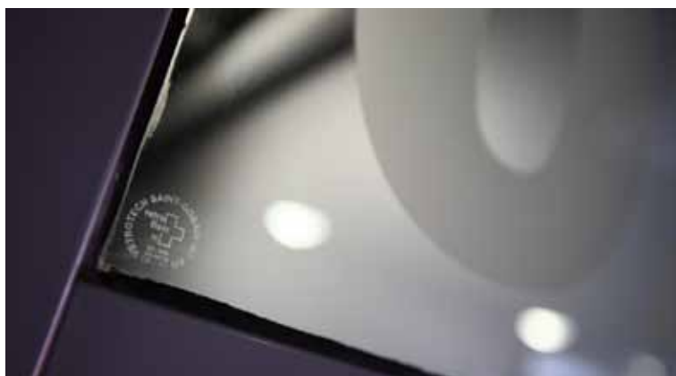
Figuur 1: Bij éénzijdig brandwerende beglazing moet de stempel leesbaar zijn vanuit het brandcompartiment.
